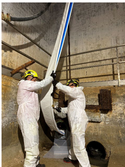
Figura 11 - Dettaglio fase inserimento liner CIPP
