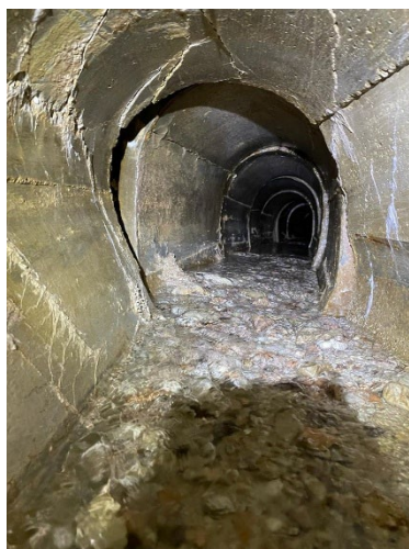
Figura 4: Stato di fatto tubazione di scarico DN500
