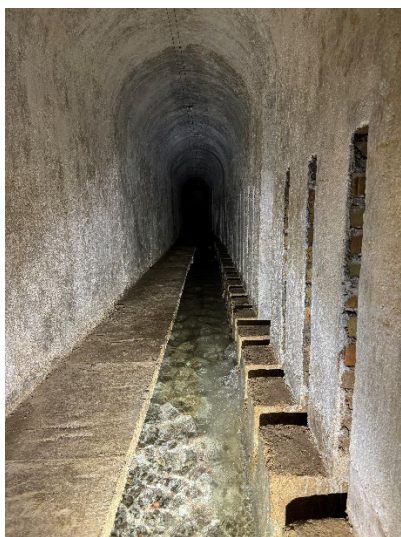
Figura 7: Edificio opera di presa
