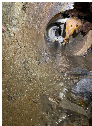
Figura 5: Stato di fatto tubazione di scarico DN500
