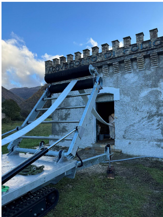
Figura 20 – Fase inserimento liner UV-CIPP
