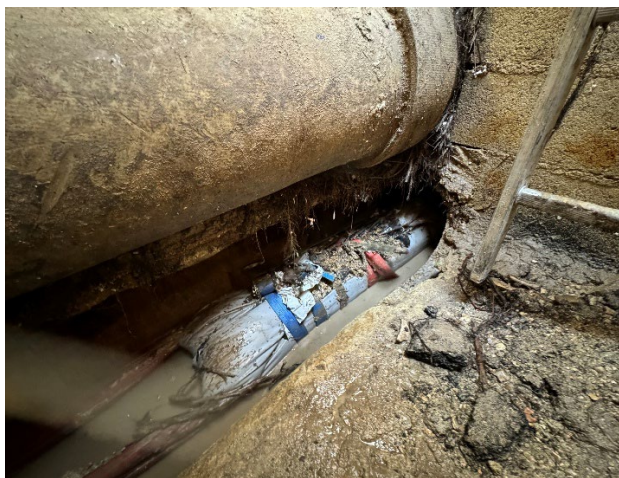
Figura 18 – Fase di tiro liner con speciale protezione
