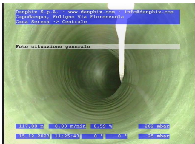
Figura 12 – Fase polimerizzazione liner CIPP
