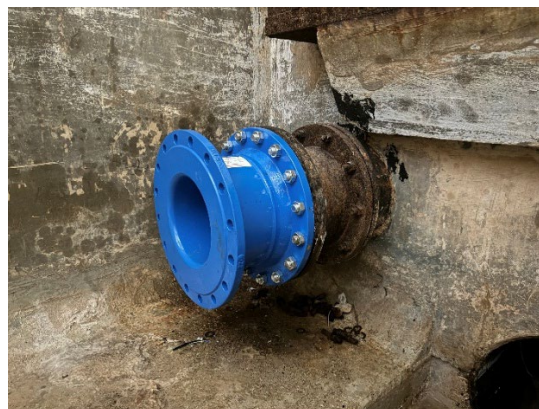
Figura 23 – Connettore di estremità Primus Line ad installazione completata
