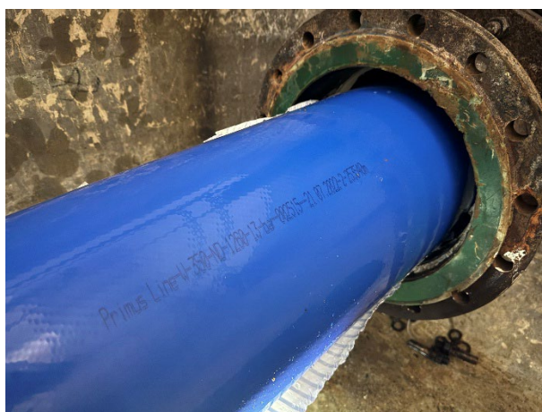
Figura 14 – Dettaglio fase gonfiaggio liner Primus Line all'interno del liner CIPP polimerizzato
