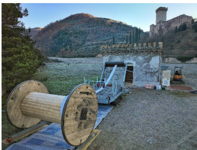
Figura 13 – Fase inserimento liner Primus Line
